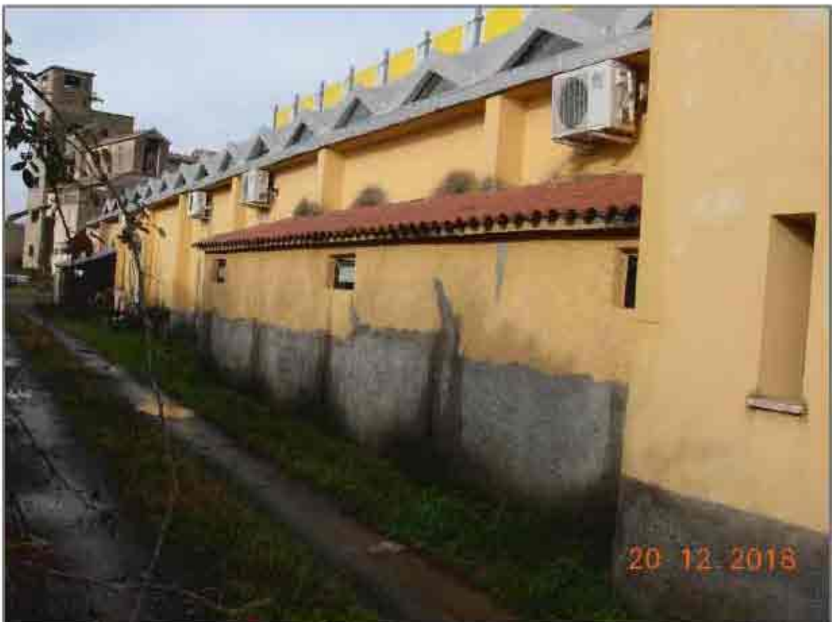
Vista lato sud
