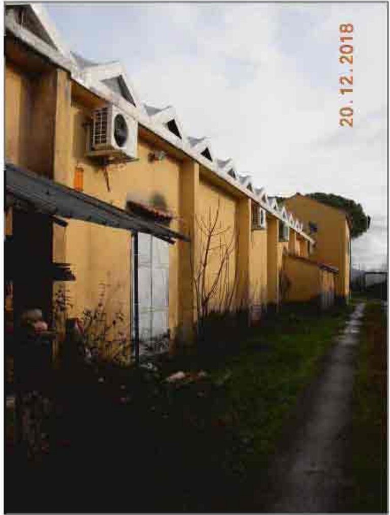
Vista lato sud
